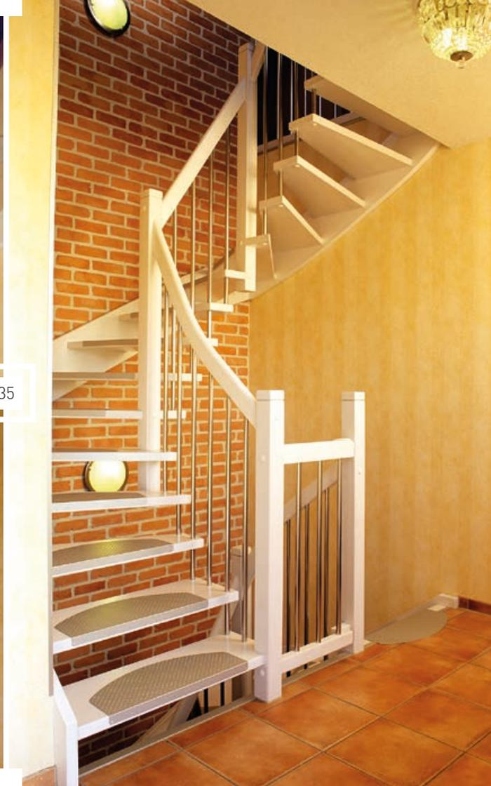
Eingestemte Wangentreppe mit Setzstufen, halbgewendelt, Holzart Iroko.
